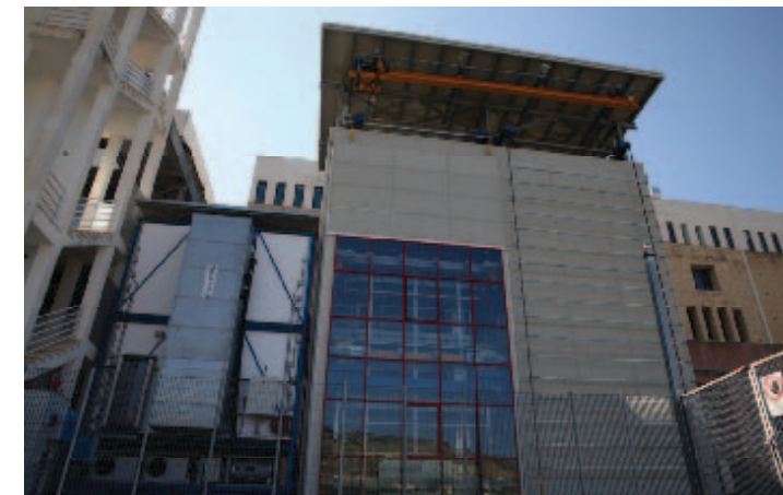
Il Test Lab del BFL di Reggio Calabria è una camera di prova su facciate che misura 15x 12 x 4.5 m ed è tra le più grandi al mondo. È in grado di testare mock-up delle dimensioni massime pari a circa 210 mq.
