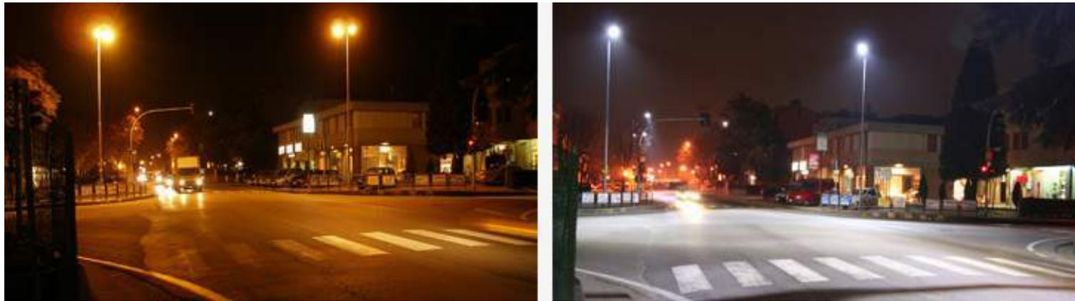
Installazione di 4 lampade G1 da 180W al posto di 6 HPS da 250W
