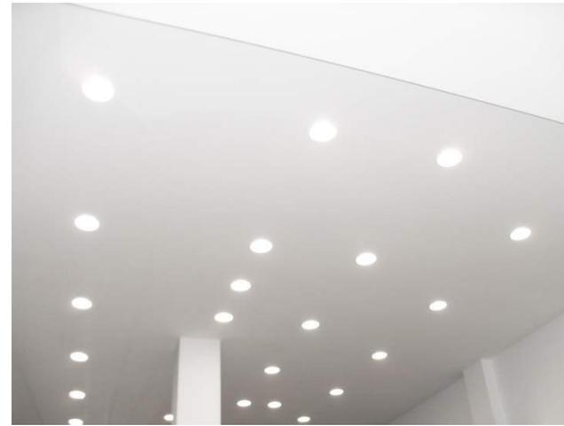
Sostituzione di 40 Disano CFL da 11W con 25 faretti da incasso CONFORT 11 (11W)
