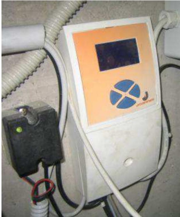
Centralina "solare": criterio di funzionamento a  $\Delta T$ .
