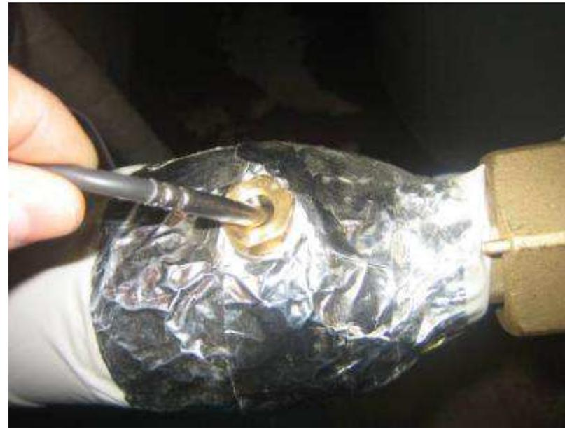
Sonde di temperatura: fissaggio inadeguato, mancanza di pasta termica
